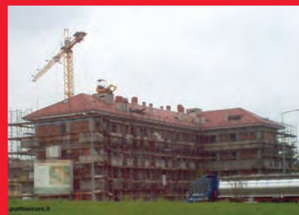
Un escavatore sul tetto
